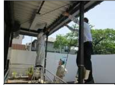
※ネット設置の様子
